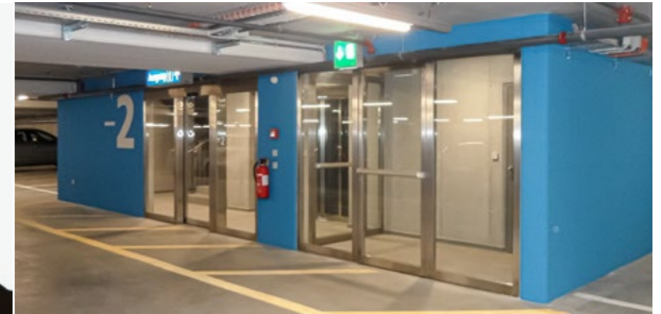
Le Schindler 5000 dans le parking de l'hôpital cantonal d'Olten
